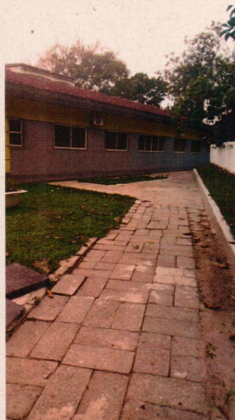
Fotos da revitalização do muro.
